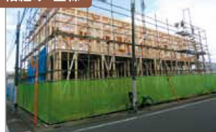
軸組み・上棟
