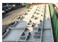
①基礎工事
