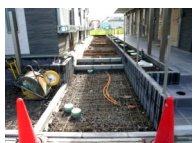
③外構・外装工事
