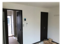
④内装工事
